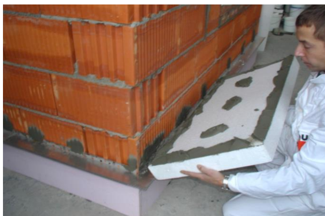
Gruntowanie Płyty styropianowe
