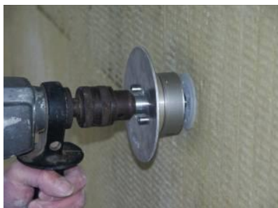
Odsadzenie łącznika
