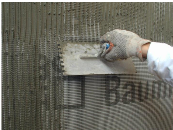
Zatapianie siatki zbrojącej w zaprawie klejowo-szpachlowej
