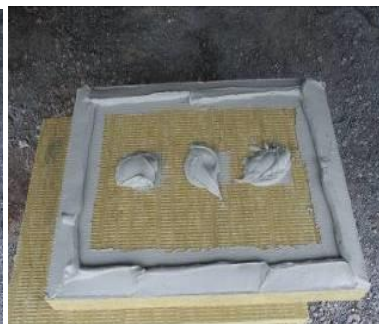
Nakładanie kleju
