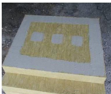
Nakładanie kleju
